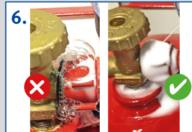
6. Am Schluss immer kontrollieren, ob der Anschluss dicht ist – der aufgespritzte Schaum darf keine Blasen werfen
